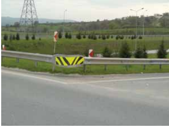
Şekil 11 Ters takılmış Refüj Başı İşaretlemesi (Görükle) ile
