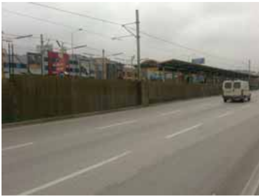
Şekil 1 Yol kenarında beton çıkıntılar
