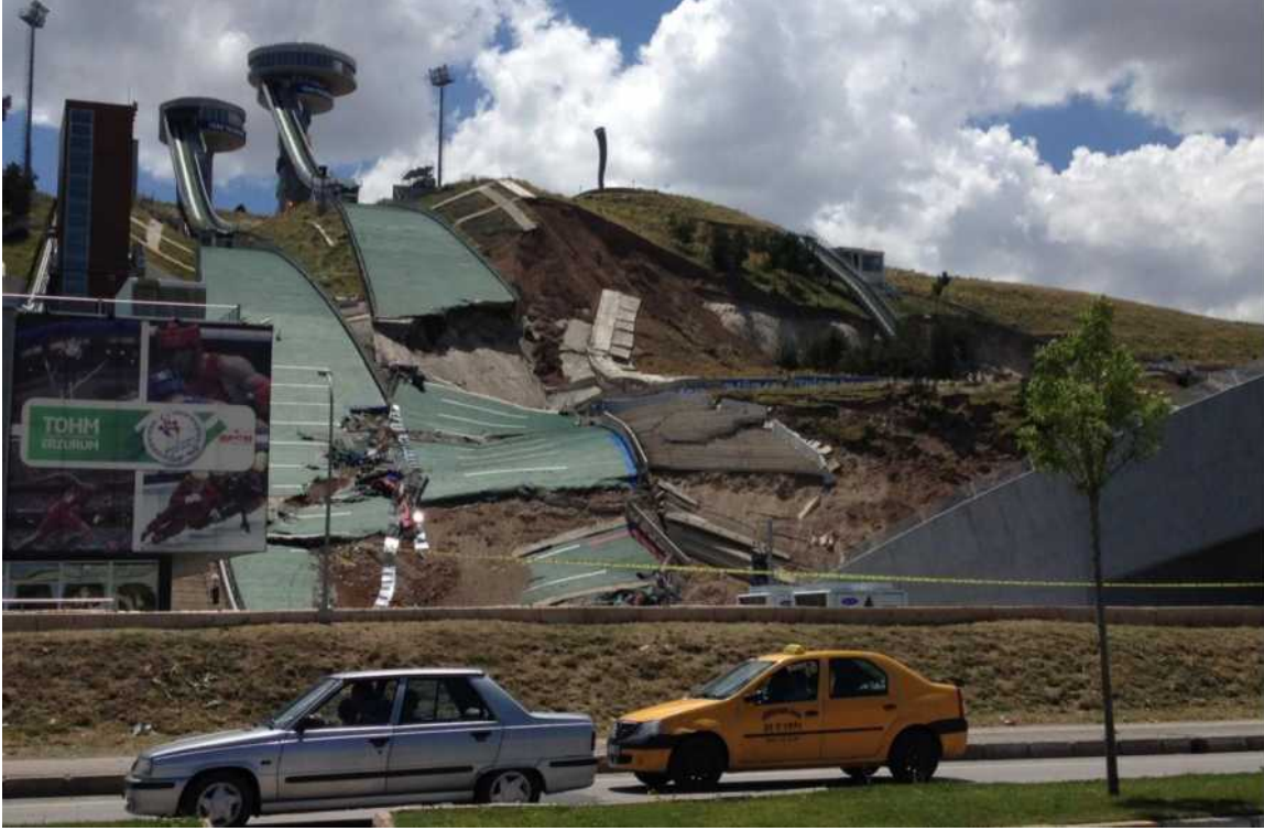
Şekil 2. Heyelan sonrası iniş rampalarındaki hasar
