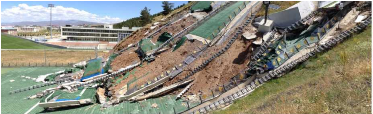
Şekil 6. Zemin üzerine yerleştirilen 40 cm kalınlığında beton iniş rampası
