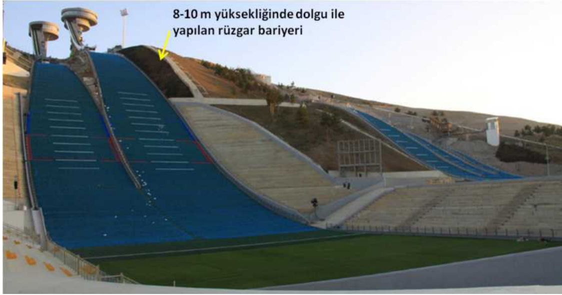
Şekil 8. Heyelan olmadan önceki zamanlardan bir görüntü. İniş rampalarının sağ tarafında rüzgârı kesmek için kahverengi dolgu toprak yığılarak oluşturulan rüzgâr bariyeri görülmektedir.
