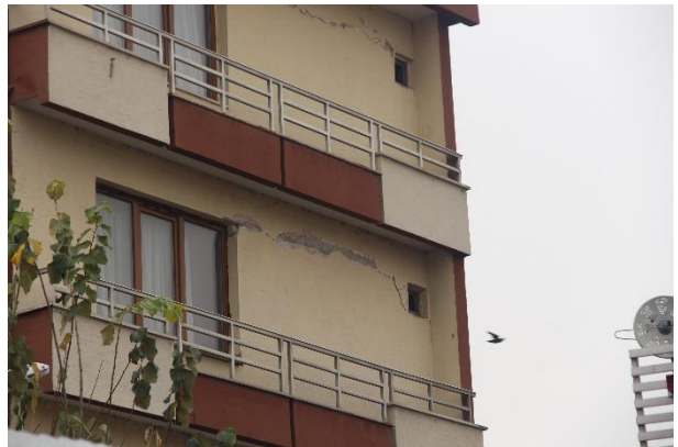
Şekil 10: Betonarme binalarda yapısal olmayan hasar örnekleri
