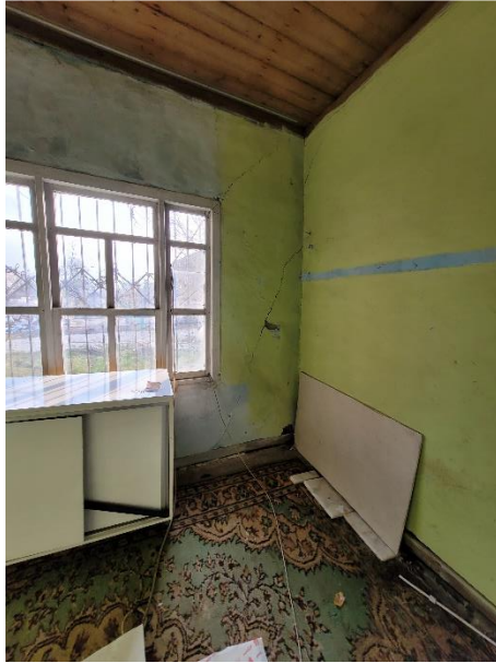
Şekil 12: Yığma binalarda yapısal hasar örnekleri (devam)
