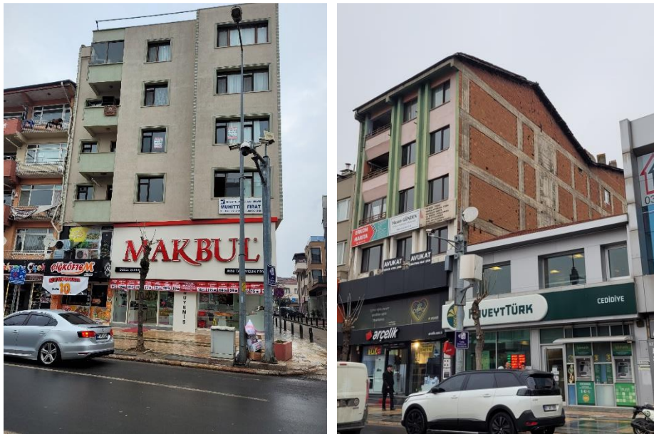
Şekil 14: Güçlendirilmiş binaların Gölyaka depremi sonrası durumları
