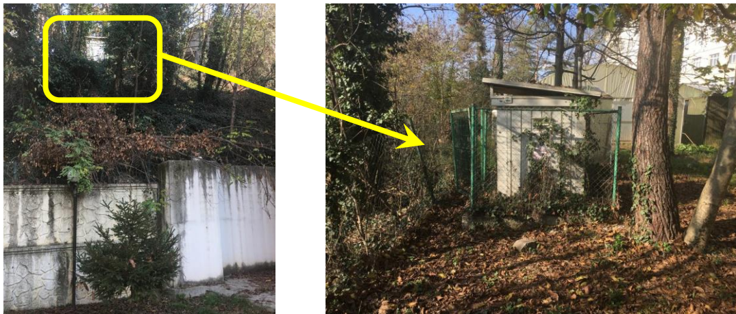
Şekil 6: 8105 kodlu kayıt istasyonunun görünüşü
