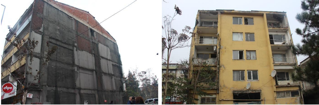
Şekil 14: Güçlendirilmiş binaların Gölyaka depremi sonrası durumları
