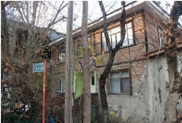
Şekil 13: Hasarsız hımış bina örnekleri
