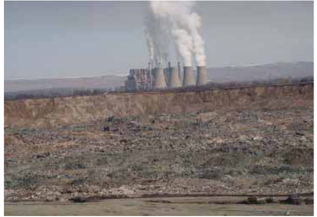
10.02.2011 Heyelanı ve A Termik Santrali (Fotoğraf 3)
