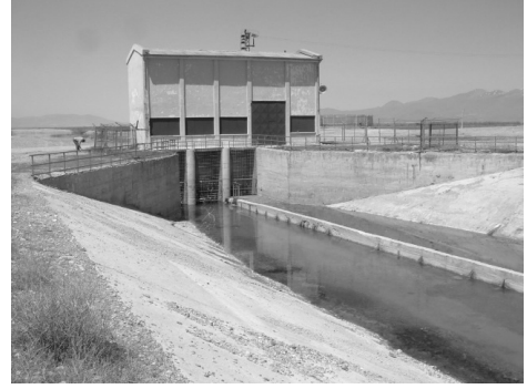
Şekil 4. Camız Gölü Pompa istasyonu ve drenaj suyunu tuzluluğuna göre ayıran tesis
