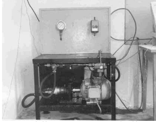
Hidrolik Presin Pompası ve Kumanda Tablosu (Pres Duvarın Arkasında)
