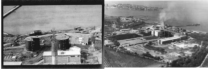
Çayırova'daki düzcam fabrikanın yapım aşamaları ve bugünkü durumu
