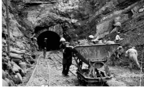
1930'lu yıllarda Tünel kazı çalışmaları.
