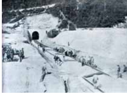
Tünel ağzında balast deposu
