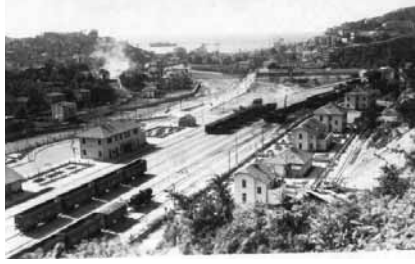
Zonguldak istasyonu yapım çalışmaları. (1937)
