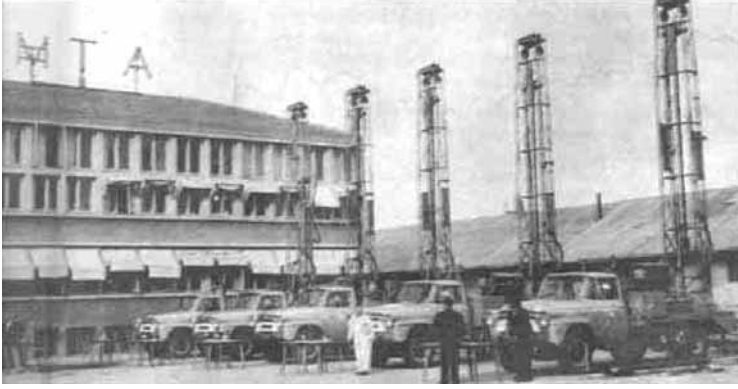
MTA'nın ilk yıllarındaki Ankara-Akköprü tesisleri
