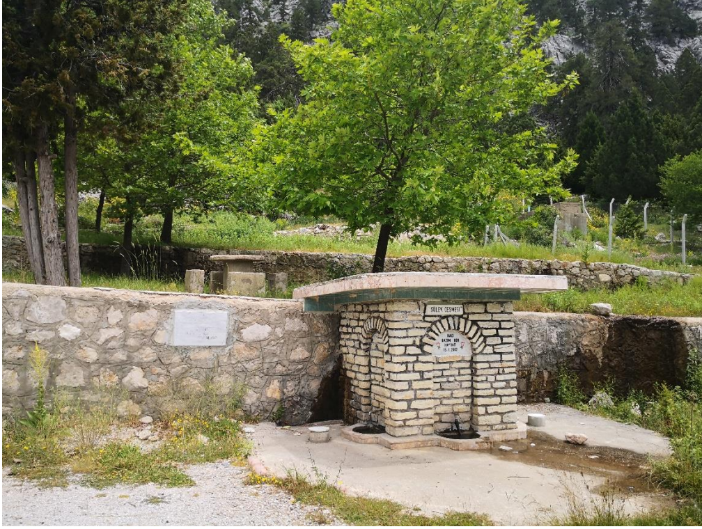
Şekil 14. Sülek kaynağı kaptajı ve çeşmesi
