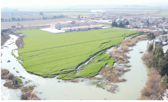
Şekil 4: Hatay şehir merkezi kuzeydoğusunda Asi nehri kollarında yer alan alüvyal düzlüklerde sınılaşma ve yanar yer değıştirmeye bağılı geniş alanlarda görülen deformasyon.
