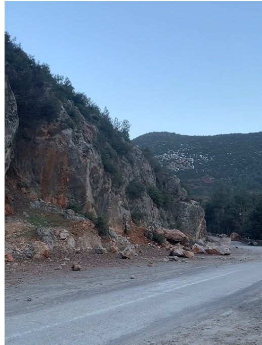
Şekil 3: Hassa çevresinde deprem sonrası oluşan kaya düşmeleri.
