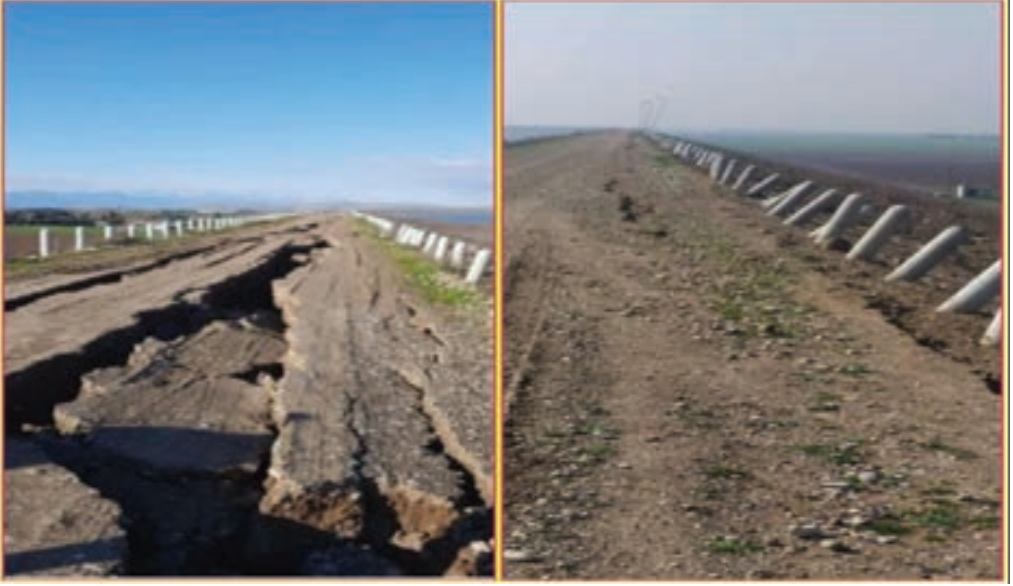
Şekil 42- Reyhanlı Barajı dolgusundan görünümler
