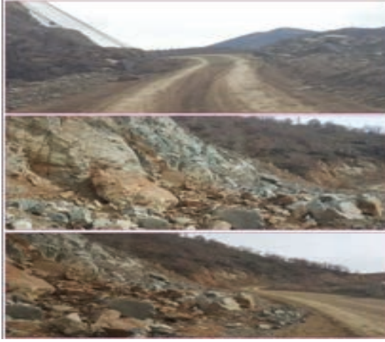
Şekil 23- Kandil barajı bağlantı yollarındaki kaya düşmeleri (sol)
