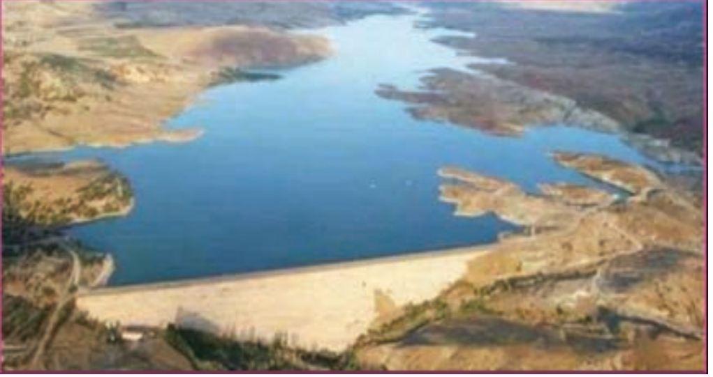
Şekil 9- Sürgü barajı dolgusu ve rezervuarı
