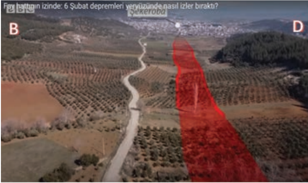
Şekil 11: 2023.02.06 (Mww_7.8) depremine ait fay zonunun Şekeroba yerleşimi güneyindeki konumu (BBC News Türkçe, Fay hattının izinde: 6 Şubat depremleri yeryüzünde nasıl izler bıraktı?)
