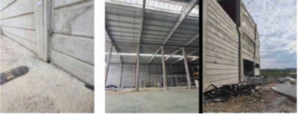
Prefabrik beton cephe panelleri ve yapısal davranışa etkileri
