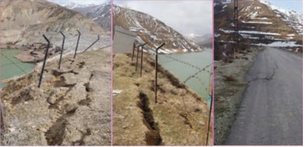
Őekil 14- Őat Barajı kretinde kayma yzeyi boyunca gzlenen hareketler
