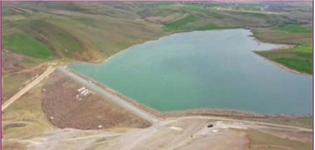
Şekil 19- Polat Barajı dolgu ve rezervuarından bir görünüm
