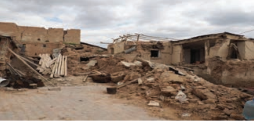
Balaban Ağır hasarlı kerpiç yapılar. Kullanıcılar, yıkılan yapıların ahşap kirişlerini toplayarak tekrar kullanmak ya da satmak için kenara diziyor.
