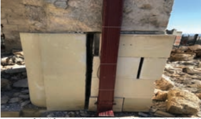
Kahramanmaraş Şekerli Cami, son dönem onarımlarında revak ayağındaki uygulamalar
