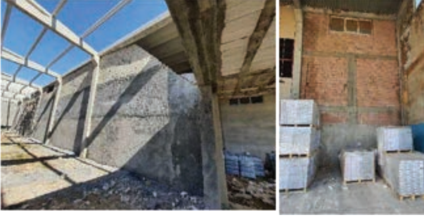
Cephe duvarlarında yatay/düsey hatılların önemi
