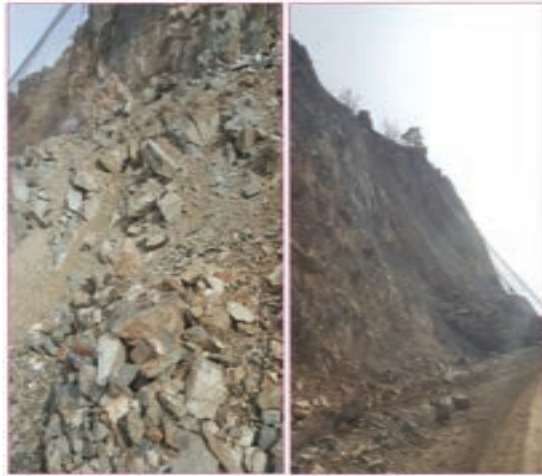
Şekil 24- Kandil barajı bağlantı yollarındaki moloz akmaları (sağ)
