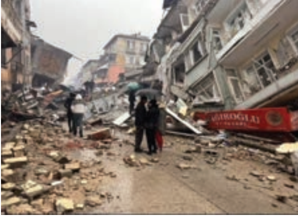
Hatay Antakya Meydan Mahallesi Kurtuluş Caddesi
