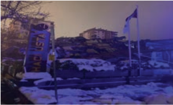
Gaziantep Batıkent Mh Kürşat Tüzmen Blv Emre Apt.
