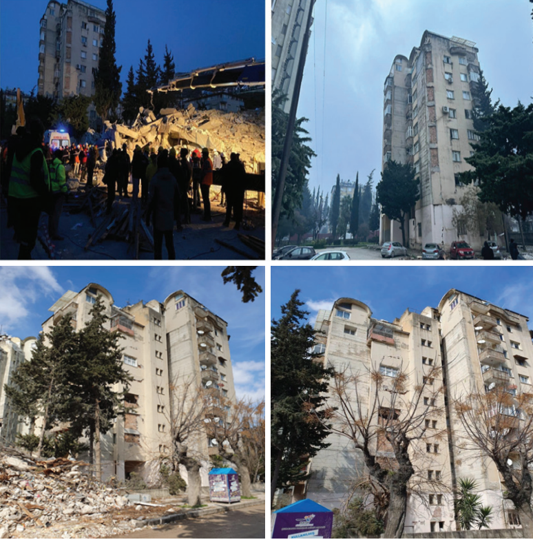
Deprem sonrası durum ve dış görünüş
