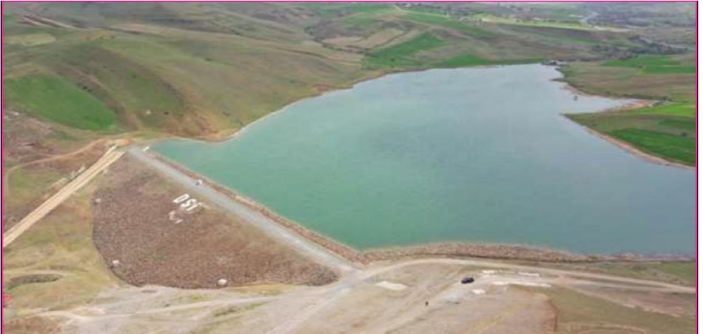
Şekil 19- Polat Barajı dolgu ve rezervuarından bir görünüm
