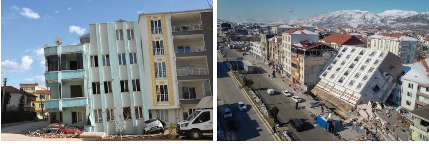
Şekil 43. Zemin sıvılaşması nedeniyle hasar almış binalar
