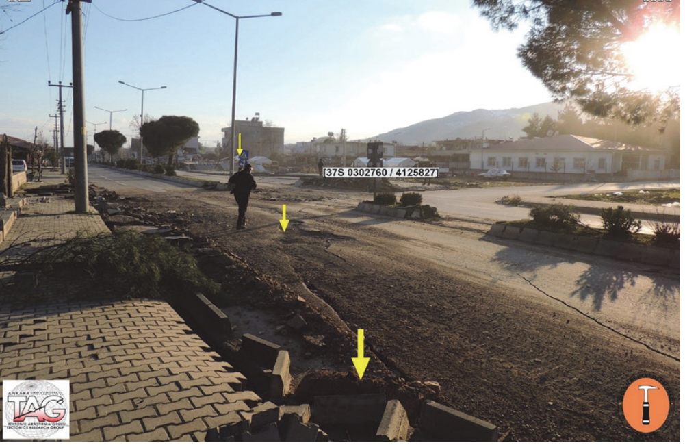
Şekil 12c: Şekeroba merkezde Belediye Caddesinde yüzey yırtılması. Konum için Şekil 12'e bakınız.
