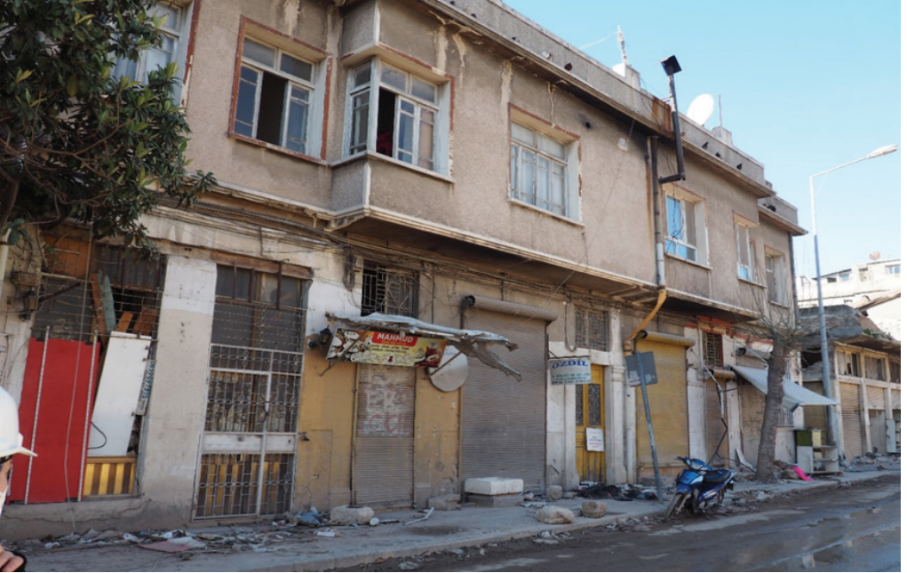
Kurtuluş Caddesi, olasılıkla 1930-40'lı yıllara tarihlenen yığma tuđla duvarlı, betonarme döşemeli yapı
