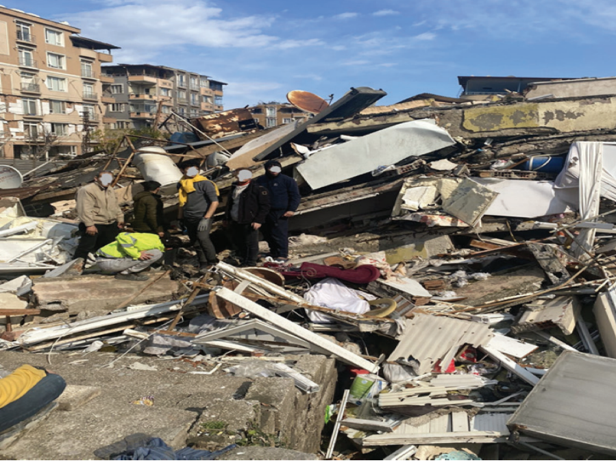
Antakya Emlakbank Evleri
