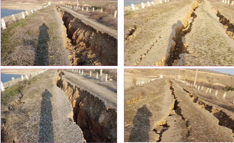
Şekil 3- Sultansuyu barajının depremden 10 gün sonraki görüntüleri
