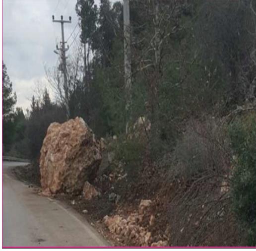
Şekil 8- Kartalkaya barajı bağlantı yolundaki irili ufaklı kaya düşmeleri
