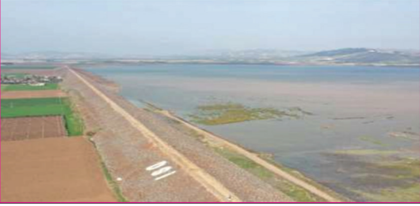
Şekil 41- Reyhanlı barajı dolgusu ve rezervuarı
