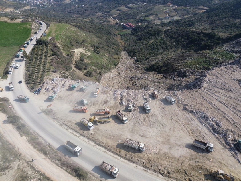
İnşaat ve yıkıntı atıklarının kontrolsüz bir şekilde vadiye dökülmesi (Fotoğraf: Erdal Can İÇELLİ)
