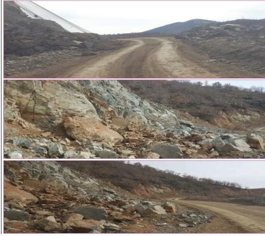
Şekil 23- Kandil barajı bağlantı yollarındaki kaya düşmeleri (sol)
