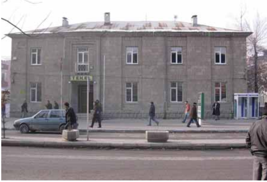
Foto 4. Tekel Binası Ankara'daki hükümet binalarını andıran mimarisi Avusturyalı mimarların elinden çıkmış gibi durmaktadır. Yapı Cumhuriyet Caddesi'nin ilk binalarındandır.
