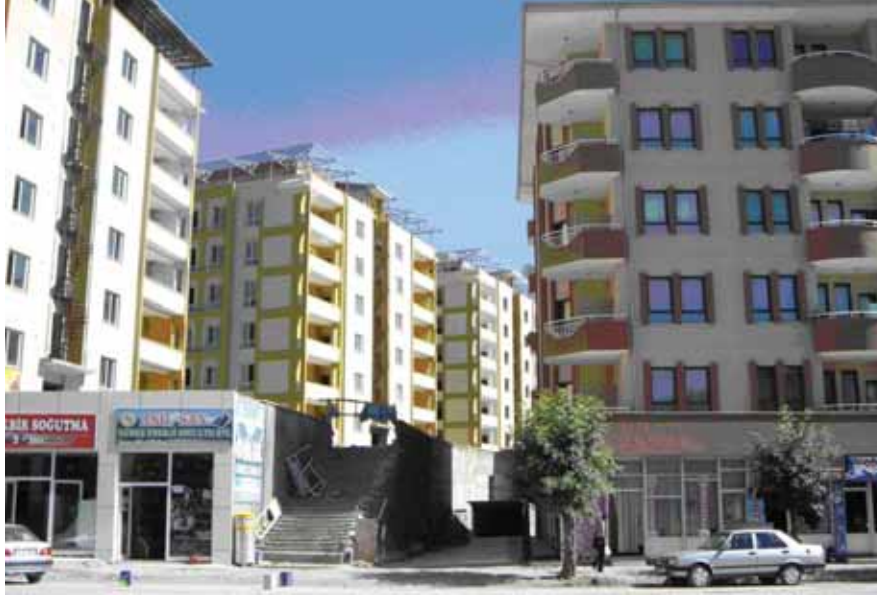
Foto 21. Beton yığını haline getirilerek kimliksizleştirilen Van sokaklarına bir örnek.
