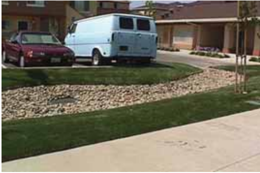
Biyo-filtre ve geçirimli döşeme uygulaması
