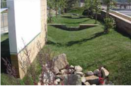
Incinitas yerleşimi su tutma ve infiltrasyon alanı
